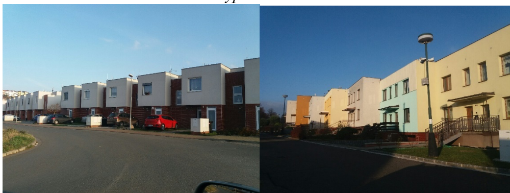
Obrázek 1: Typická řadová zástavba
