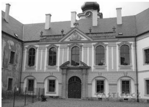
Obrázek 3: Průčelí západního křídla po obnově
