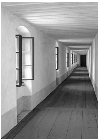
Obrázek 4: Pohled do spojovací chodby těsně před dokončením
