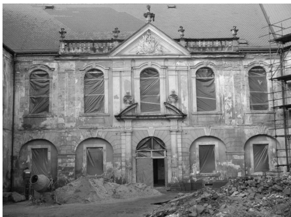
Obrázek 2: Průčelí západního křídla před obnovou
