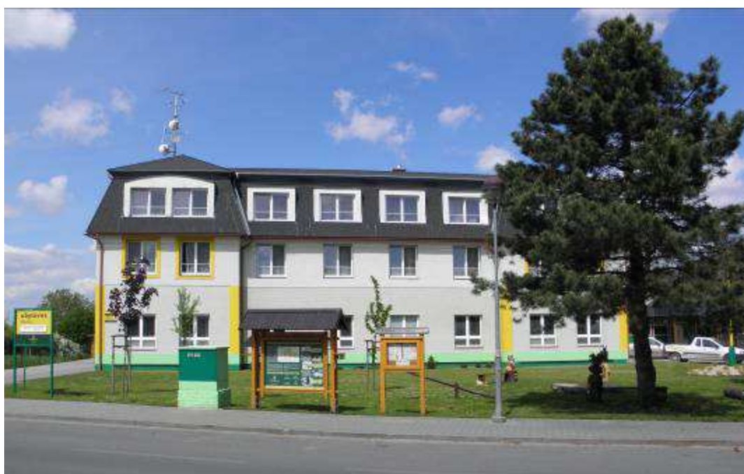
Obrázek 3: Budova ředitelství ML s ubytovnou
